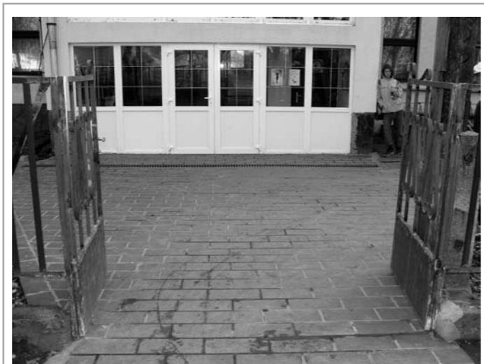
Elkészült az iskola előtti terület térkövezése
